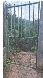
Foto 6: sustitución de porton de metal
